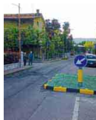
Lavori per la viabilità
